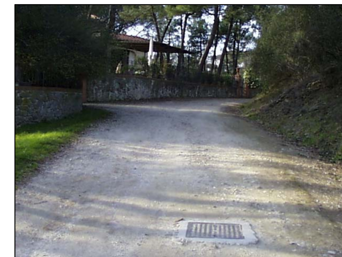
6 POZZETTO FOGNATURA IN FONDO ALLA STRADA STERRATA
