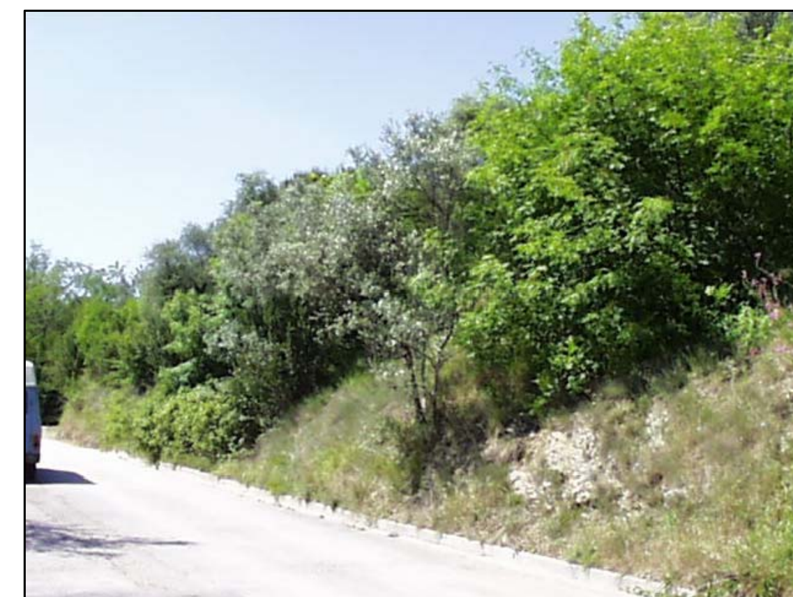
5 SCARPATA LUNGO VIA DEI PINI
