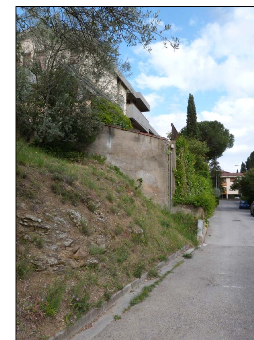
10 MURO IN CEMENTO ARMATO DELL'EDIFICIO PEEP A MONTE CON ARMADIETTO ENEL
