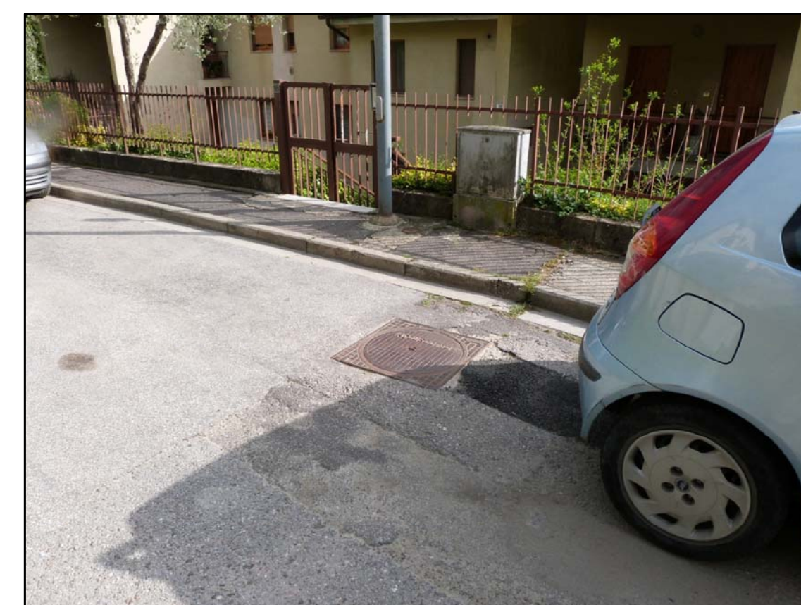
13 POZZETTO ACQUEDOTTO SULLA STRADA
