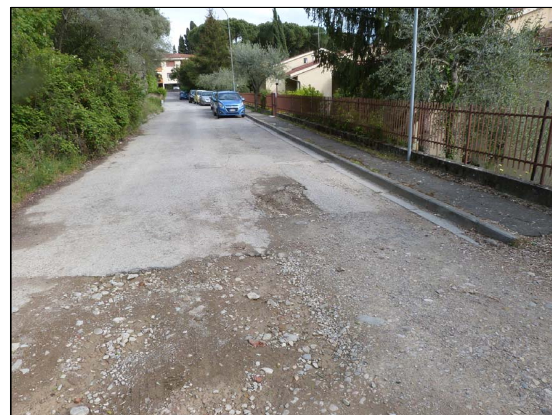
4 TRATTO FINALE ASFALTATO DI VIA DEI PINI
